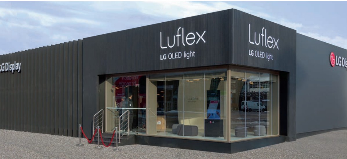
Auch ein Temporärbau muss höchsten Komfort bieten: Hohlräumige Doppelwände halten Kälte fern.
